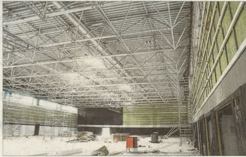
In der Turnhalle werden gerade die Prallwände montiert.
