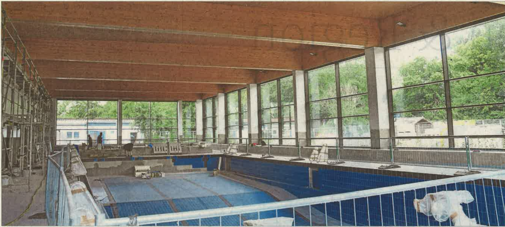
Holz statt Beton: Die neue Deckenkonstruktion bringt Wohlfühlatmosphäre in die Schwimmhalle.
